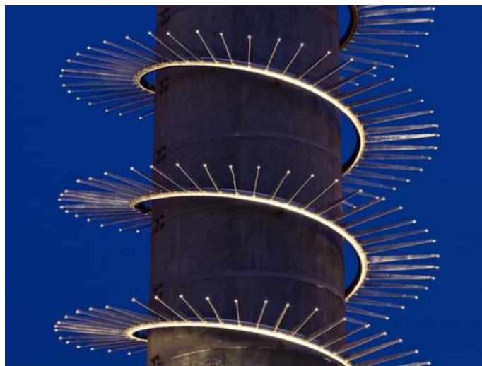
(L'elemento elicoidale del campanile-ciminiera della Chiesa del Santo Volto in Torino; foto tratta da http://www.diocesi.torino.it )
